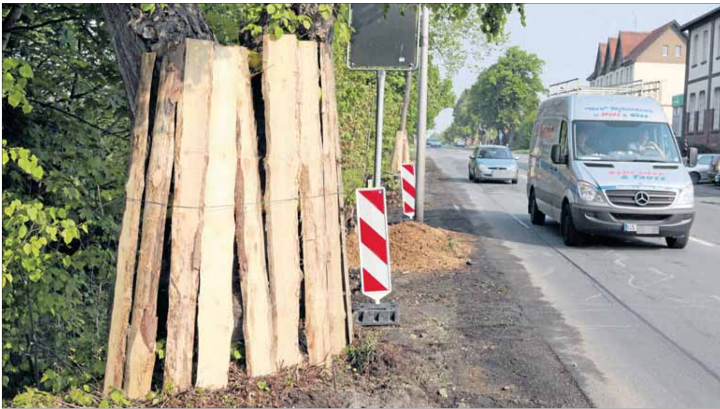
Bretter schützen die Bäume an der Hildesheimer Straße, deren Asphaltdecke nach dem harten Winter mit Schlaglöchern gepflastert ist. Jetzt wird die Fahrbahn grundlegend saniert. Fotos: Schenk
