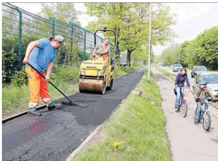
Der Fußweg an der Straße „Im Schleeke“ erhält eine neue Asphaltdecke. Auf einer Länge von 300 Meter wird saniert.
